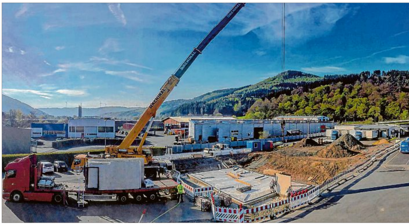
Für 2,5 Mill. Euro entsteht auf dem Gelände der Otto Blecher GmbH in Bad Laasphe ein neuer Verwaltungsstrakt des Unternehmens. Weitere 1,5 Mill. Euro wurden in die Produktion investiert. Fotos: Unternehmen/Holger Weber
