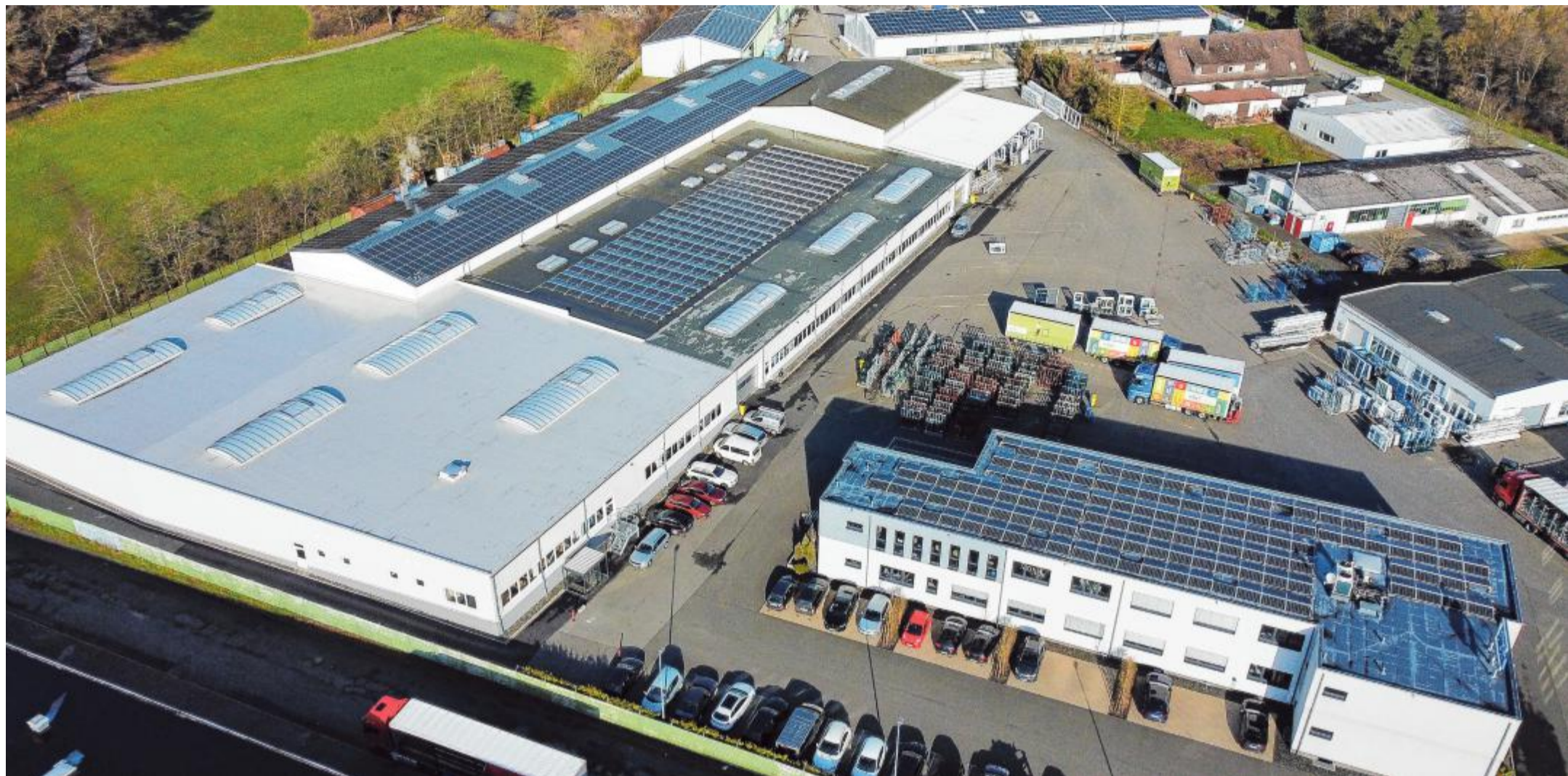
Die Otto Blecher GmbH hat die Produktion in Bad Laasphe um 2800 Quadratmeter erweitert und fünf Millionen Euro investiert. Foto: Otto Blecher GmbH
